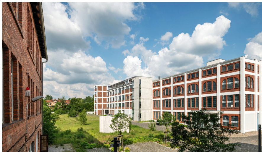
Das vom Bauhaus-Architekten Egon Eiermann erbaute heutige Industriedenkmal beherbergt das Thüringer Zentrum für Telemedizin. Bild: © Thomas Müller
