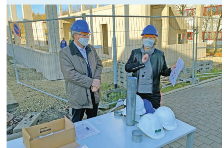
Der Grundstein für das neue Entwicklungszentrum ist gelegt. Bild: Antennentechnik Bad Blankenburg GmbH
