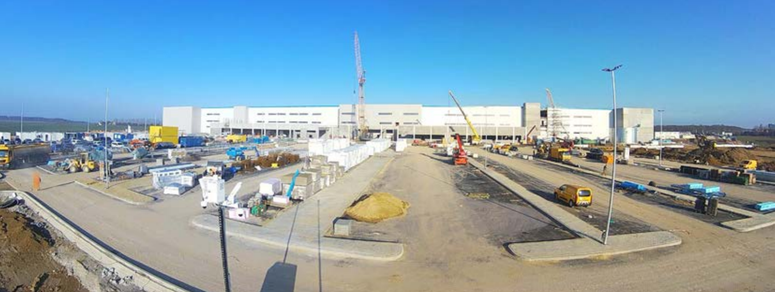
Rasanter Baufortschritt auf der Baustelle des Amazon Logistikzentrums. Bild: Amazon
