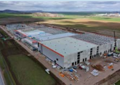
Baufortschritt der Batteriefabrik von CATL am Erfurter Kreuz. Bild: CATL
