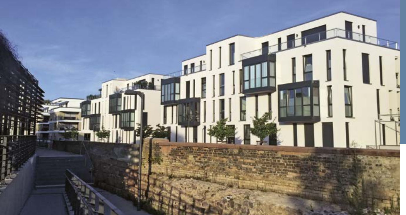
Landau in der Pfalz, Rheinland-Pfalz | Wohnpark Queichpromenade
