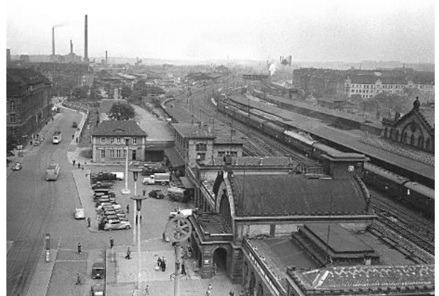
Bahnhofsvorplatz. 1950. Blick Richtung Osten
