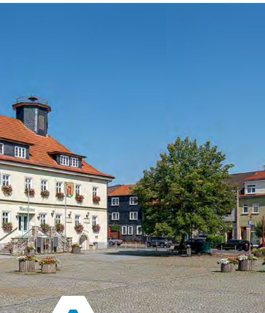
Die Sanierungsmaßnahmen in Langewiesen sind weit fortgeschritten; sichtbares Zeichen hierfür ist der neu gestaltete Marktplatz
