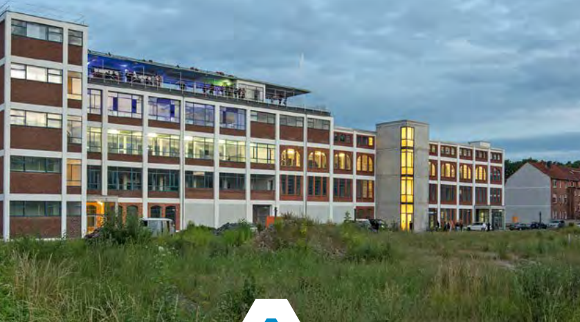
Ikone der Industriearchitektur in Thüringen: Den Ende 2017 erworbenen Eiermannbau in Apolda hat die LEG an die IBA Thüringen vermietet.
