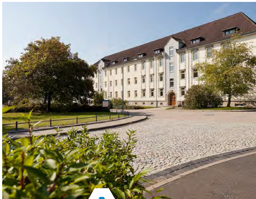
Teilansicht der ehemaligen Görmar-Kaserne in Mühlhausen
